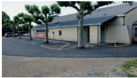
Aménagement au sud de la salle des fêtes
