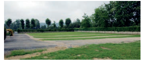
Au niveau du nouveau cimetière création de 3 allées supplémentaires et extension du réseau d'eau pour installer 1 point d'eau supplémentaire à l'opposé de l'existant
