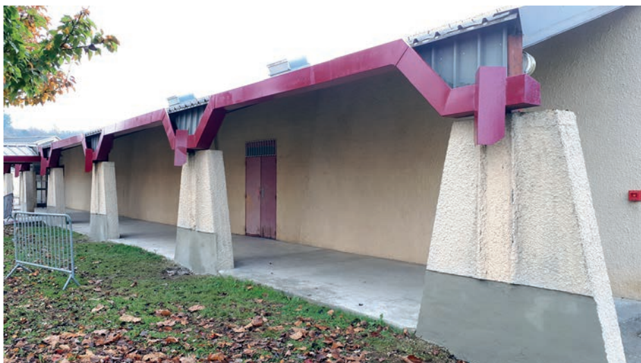
Ravalement de façades de la salle des fêtes en cours
