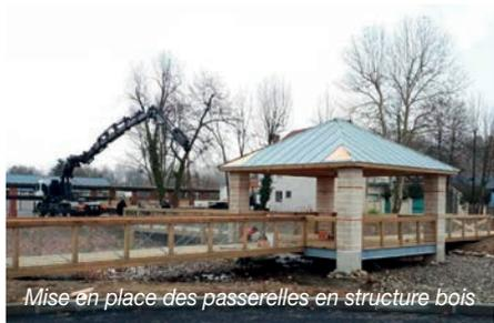
Mise en place des passerelles en structure bois
